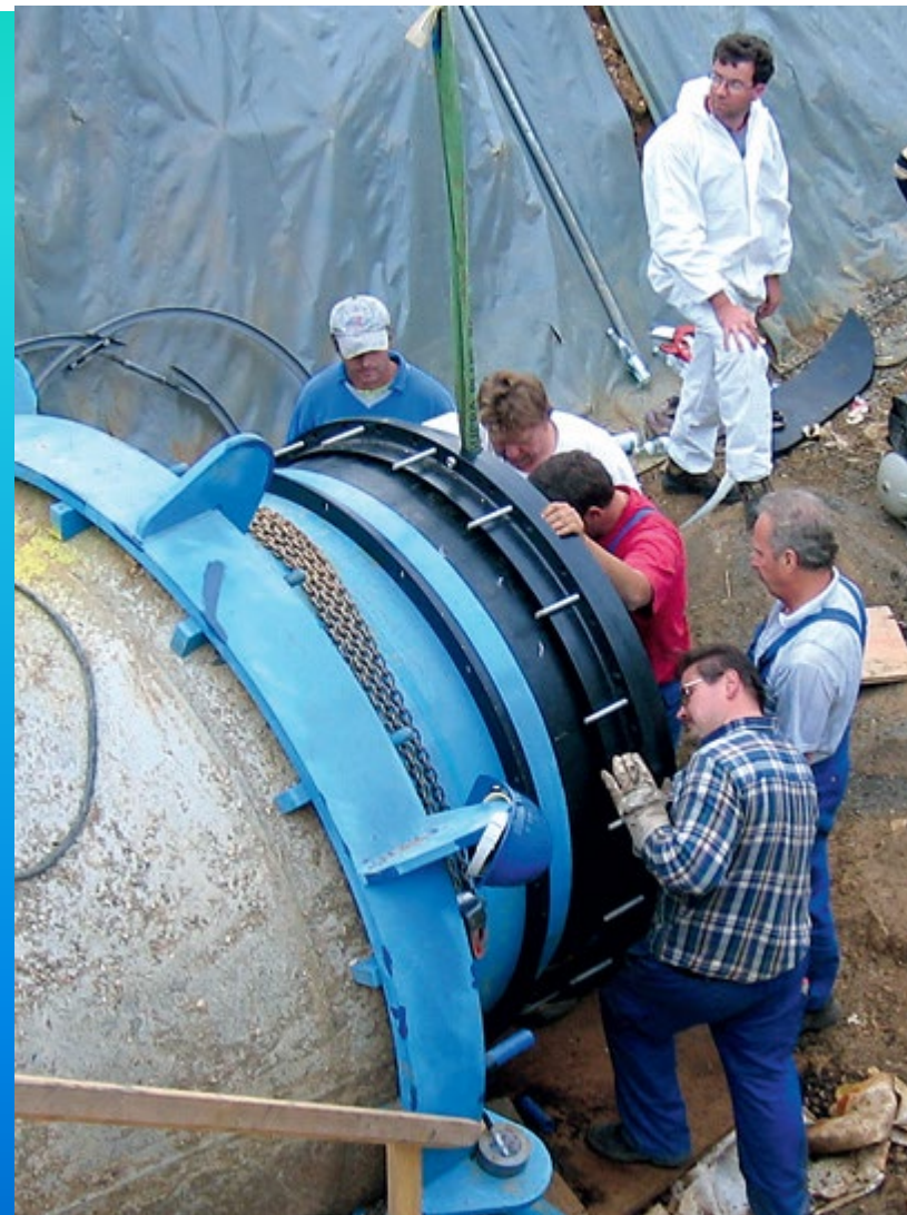
Un proyecto de rehabilitación empleando una camisa de polietileno de pared delgada SDR51 por el interior de la tubería de fundición existente.
